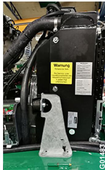
Fig. 35 Motorrum höger sida
