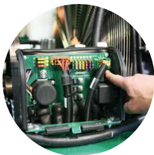
Kretskort i motorutrymme för kraftmatning
