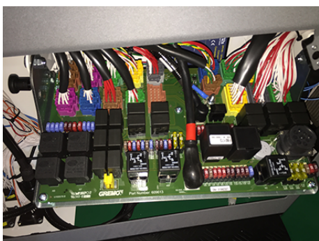
Bild 156 Sicherungskasten der Kabine
