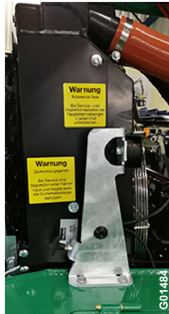
Bild 34 Motorraum, linke Seite
