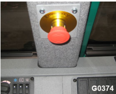
Bild 90 Notausschalter in der Kabine
