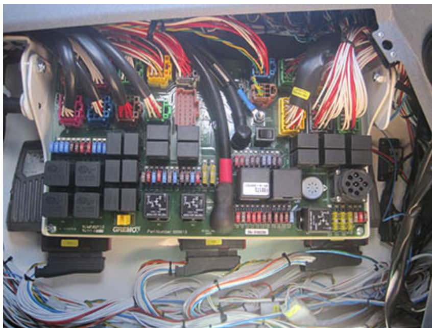
Bild 146 Verteilerkasten in der Kabine
