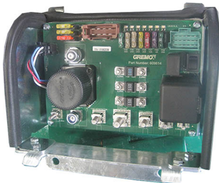
Bild 145 Sicherungsliste: rechter Motorraum
